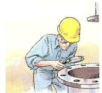
Schrauben, Muttern und Unterlegscheiben sind auf Risse zu prüfen. Die Dichtflächen sind auf Verwerfungen und radiale Kratzer zu untersuchen. Beschädigte Komponenten sind auszutauschen. Die verwendete Flachdichtung muss in Material und Dimension der Spezifikation entsprechen.
