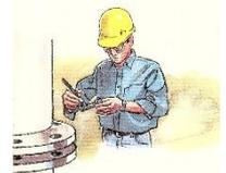
Die Schrauben werden stets „über Kreuz“ angezogen. Dabei sollten nach dem „handfesten“ Anziehen (**Achtung:** vor allem bei Graphitdichtungen die erste Schraube nie zu fest anziehen) mindestens drei Durchgänge verwendet werden, bei denen das Anziehdrehmoment von ca. 30 über 60 auf 100% gesteigert wird. Abschließend sollte jede Schraube noch einmal nacheinander im Uhrzeigersinn kontrolliert werden.
